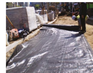
4. Geotextile 설치
